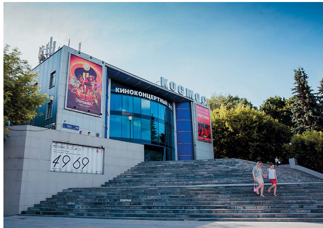
2018 Текущий ремонт кинотеатра
