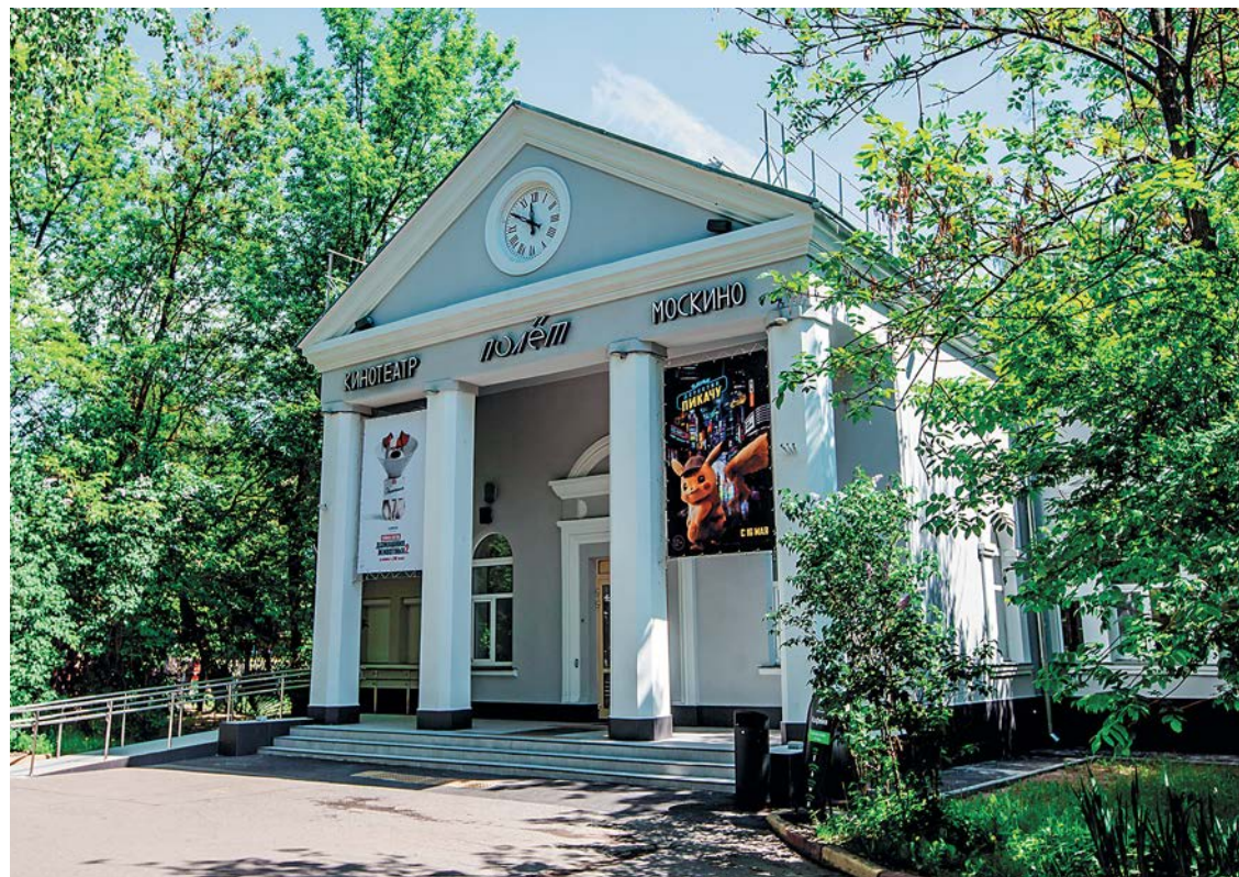
2018 Текущий ремонт кинотеатра
