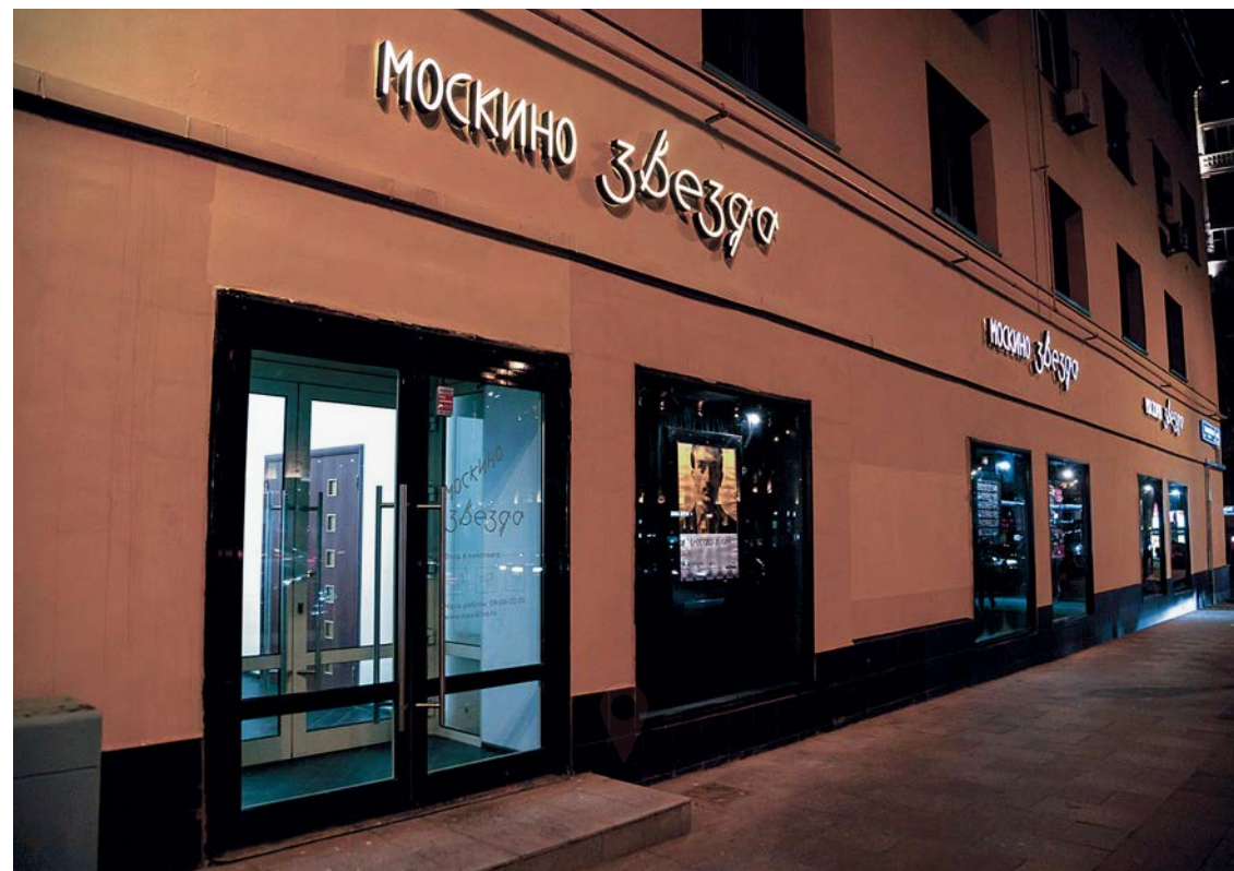
2018 Текущий ремонт кинотеатра
