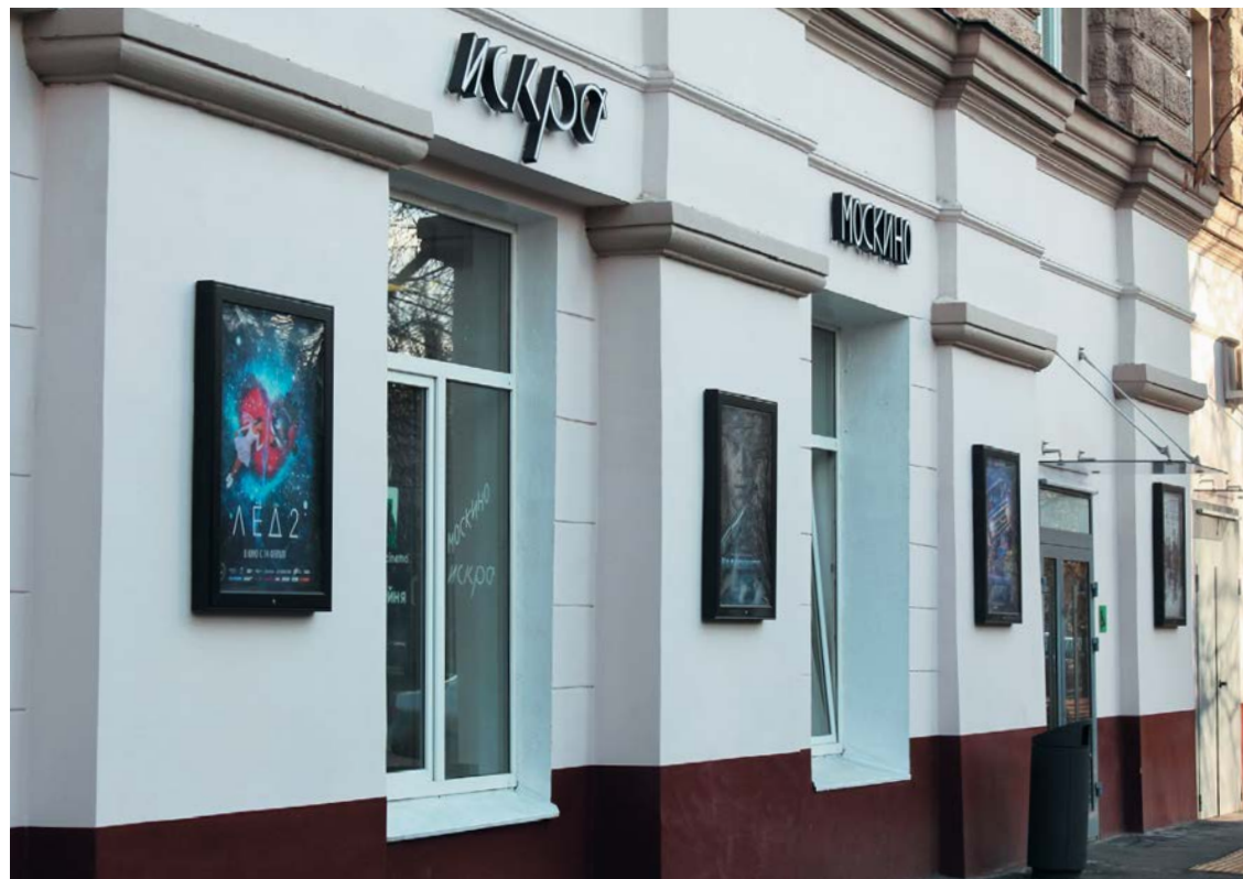
2019 Текущий ремонт фасада
